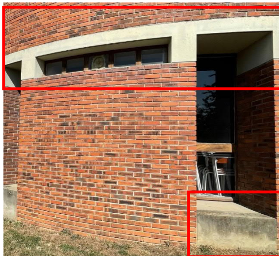
Eléments en béton à repeindre
